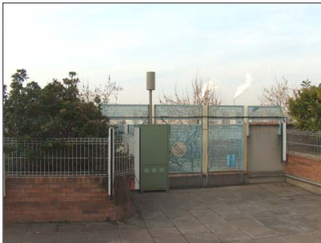
Site de Charenton-le-Pont, lors de la phase de mesure complémentaire menée autour d'Ivry-sur-Seine
